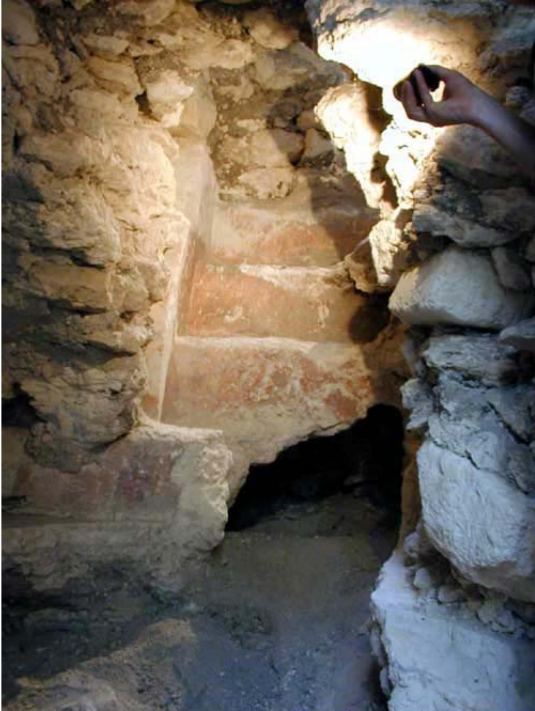
Figura 46. Fase 1 de la Estructura 5. Escalera enterrada pintada de rojo y molduras de terraza.
