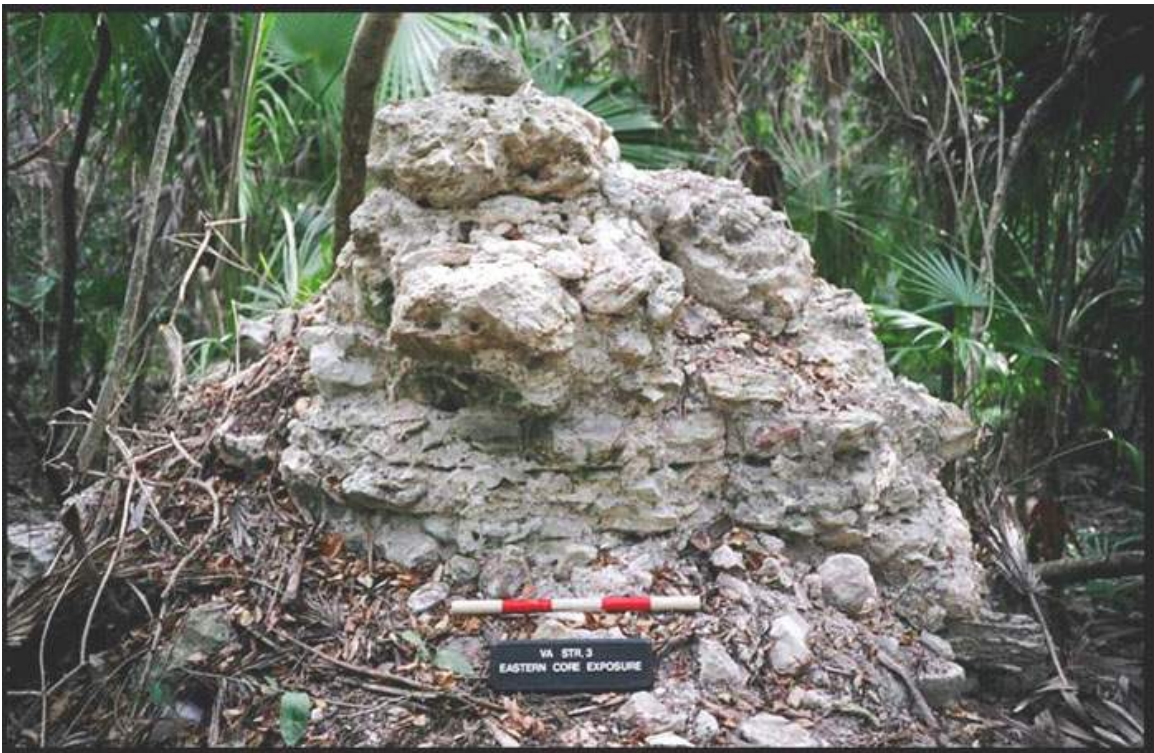
Figura 22. Estructura 3, relleno de concreto intacto (lado este).
