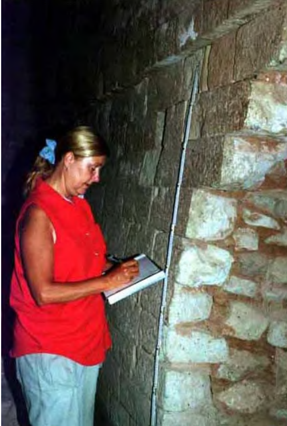
Figura 8: La arqueóloga del proyecto, Christine W. Carrelli (Universidad de Rutgers), mide, describe y hace bocetos de la fachada de una plataforma profundamente enterrada dentro de la Acrópolis. El catálogo arquitectónico creado a través del registro meticuloso de todas las plataformas, edificios, pisos, y hasta episodios de relleno que componen la Acrópolis, hace posible calcular la cantidad de mano de obra invertida y estudiar los cambios en los métodos constructivos y en los estilos a lo largo del tiempo.
