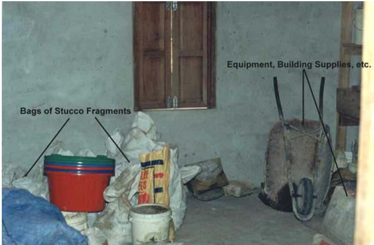
Figura A1:4. La pared vacía de la bodega contra la cual se construirá la nueva estantería.
