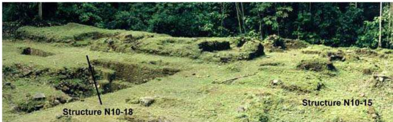
Figura 2:2. Estructura N10-18, detrás de la cual está la gran fachada del complejo de Plaza N10-3. La parte occidental de la Estructura N10-15 está a mano derecha.
