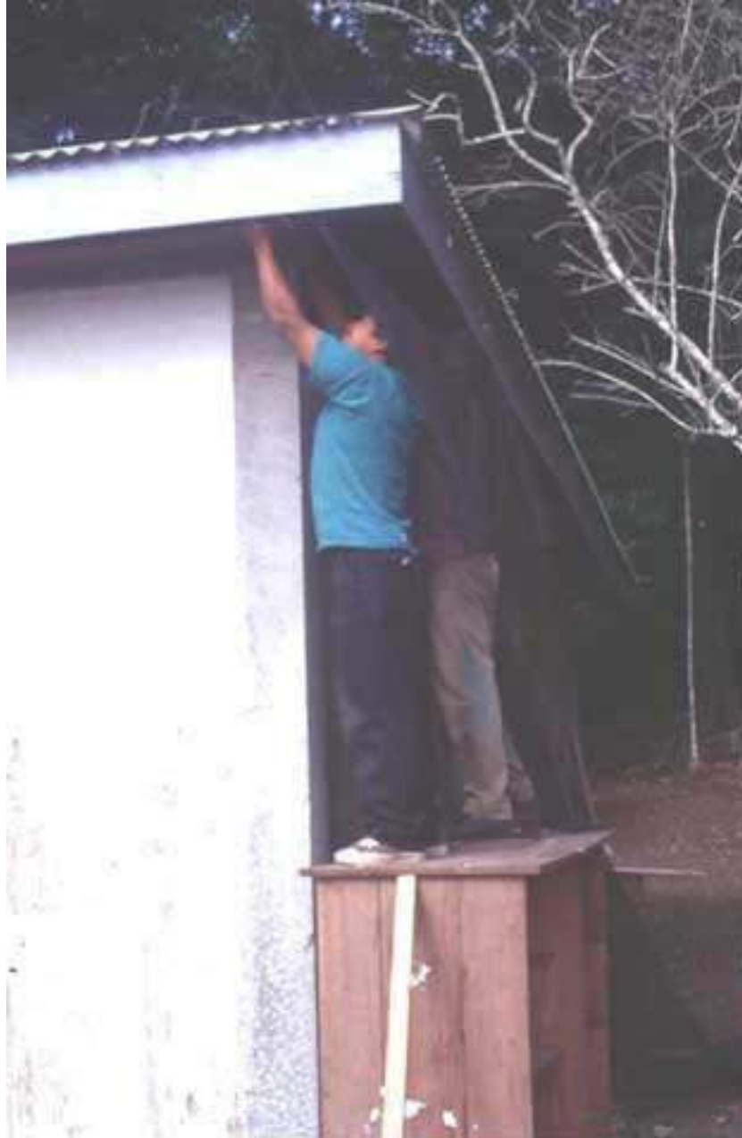
Figura A1:12. Federico e Israel instalando los cerramientos.
