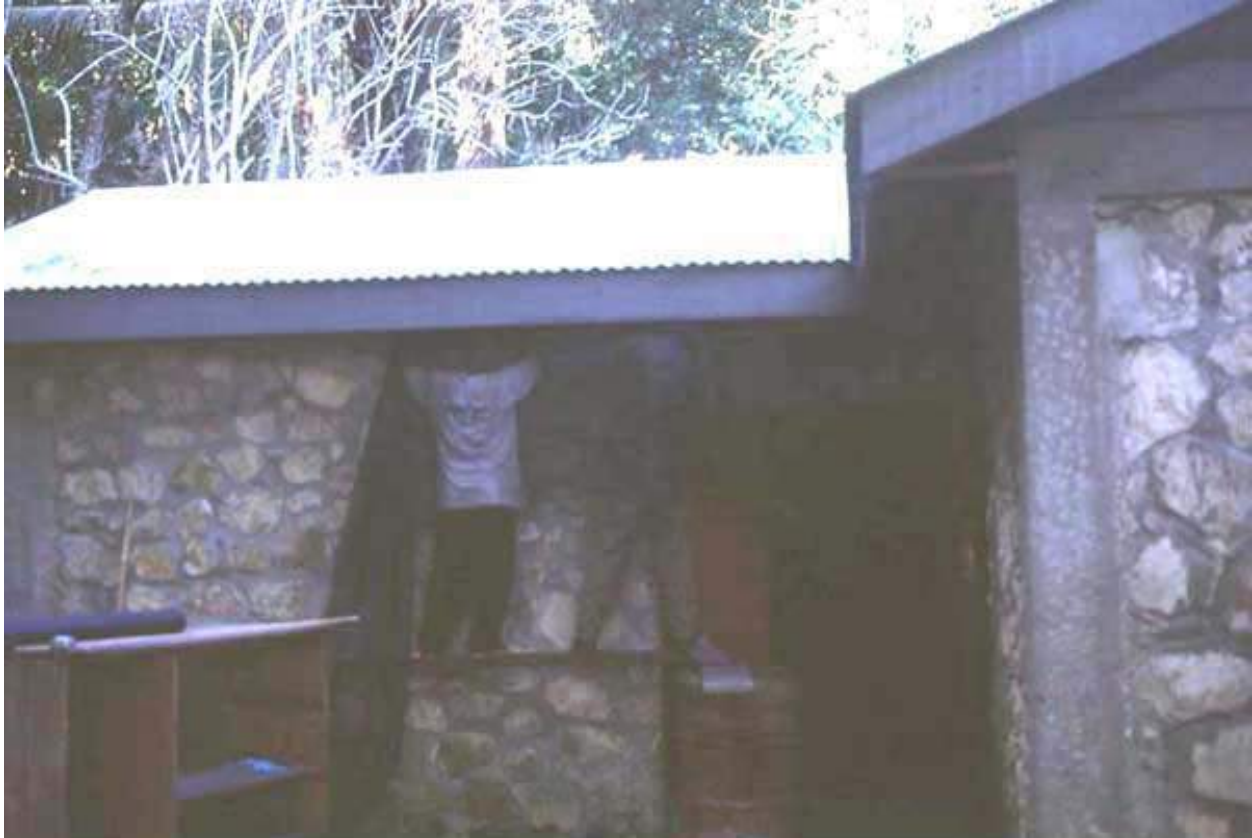
Figura A1:13. Federico e Israel instalando los cerramientos junto a la entrada de la bodega.
