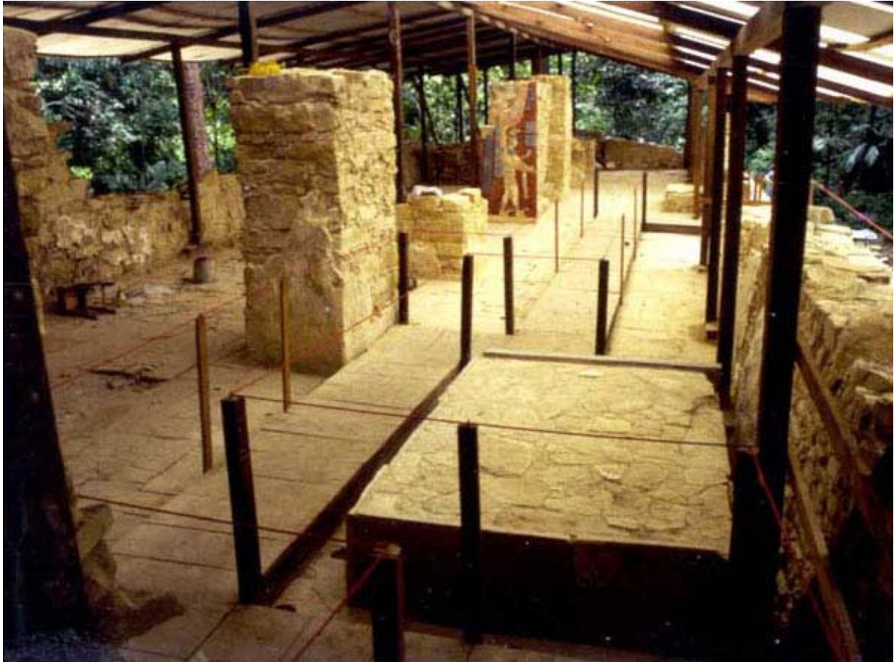
Foto 57. Palenque, Estructura XIX después de su restauración. Muestra un andén para turistas y techo protector. No hay paredes laterales de modo que la ventilación es constante, y la sombra de los árboles ayuda a estabilizar la temperatura del ambiente interior, julio del 2000.
