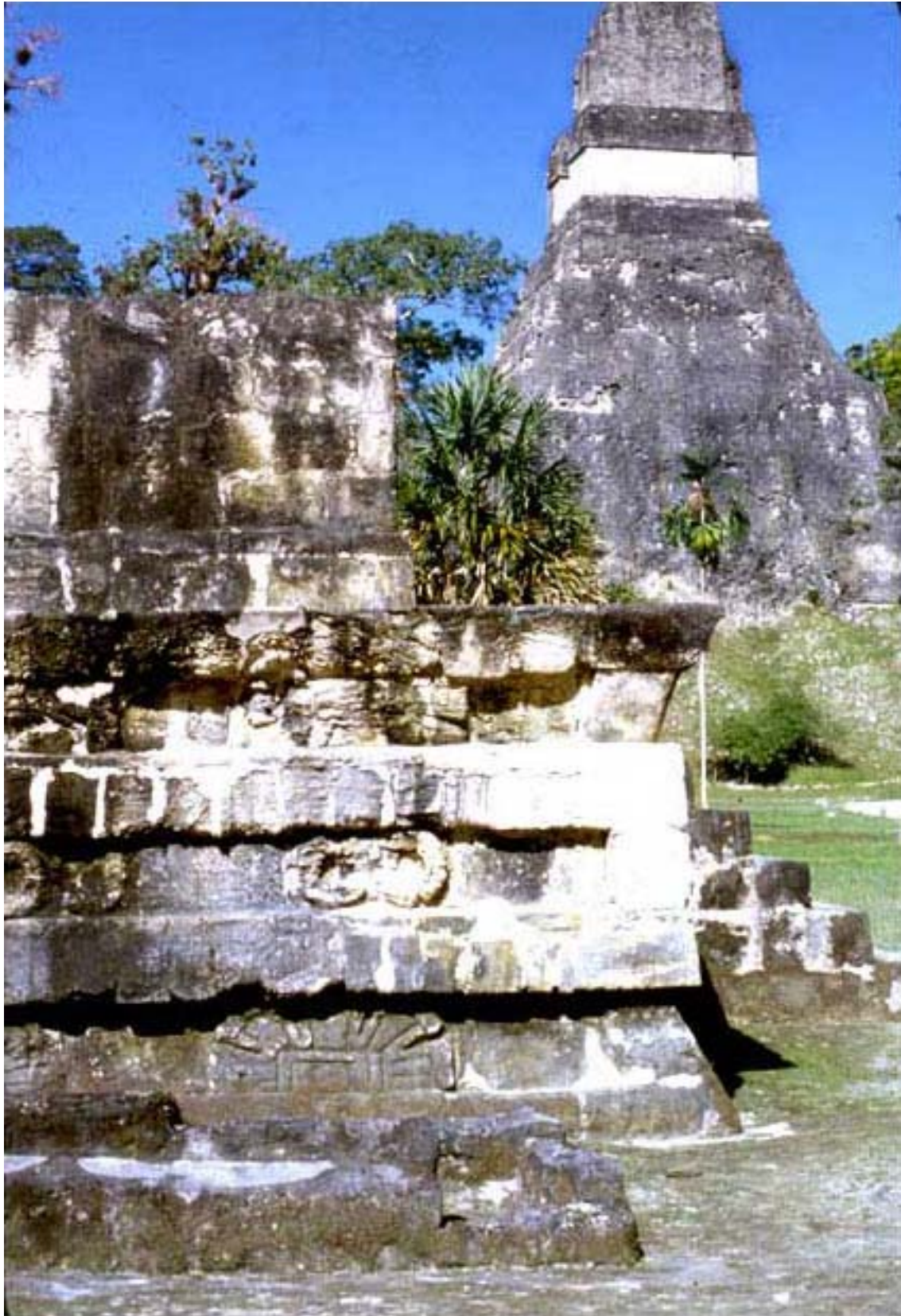
Foto 42. Tikal, Estructura 5D-43 con el Templo 1 al fondo, y un estado de avanzado deterioro de la piedra, febrero de 1980.
