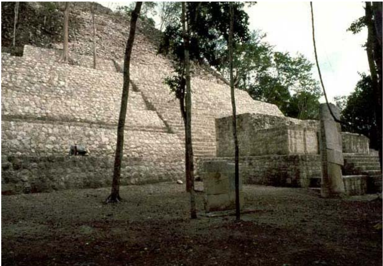
Foto 21. Calakmul, Estructura 1, restitución de volúmenes como parte del proceso de restauración, 25 de julio, 2000.
