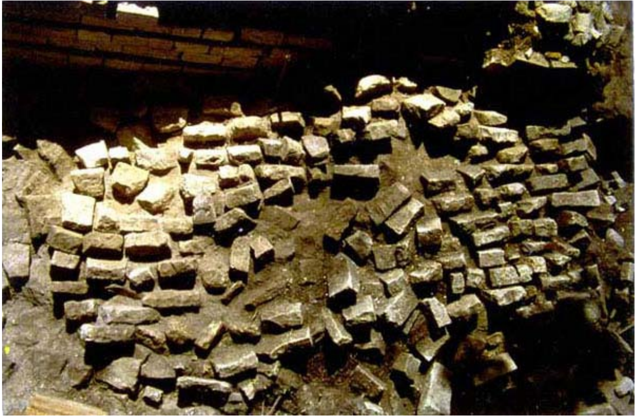
Foto 4. Copán, muro oeste, caído, Estructura 10L-22A, 1988.
