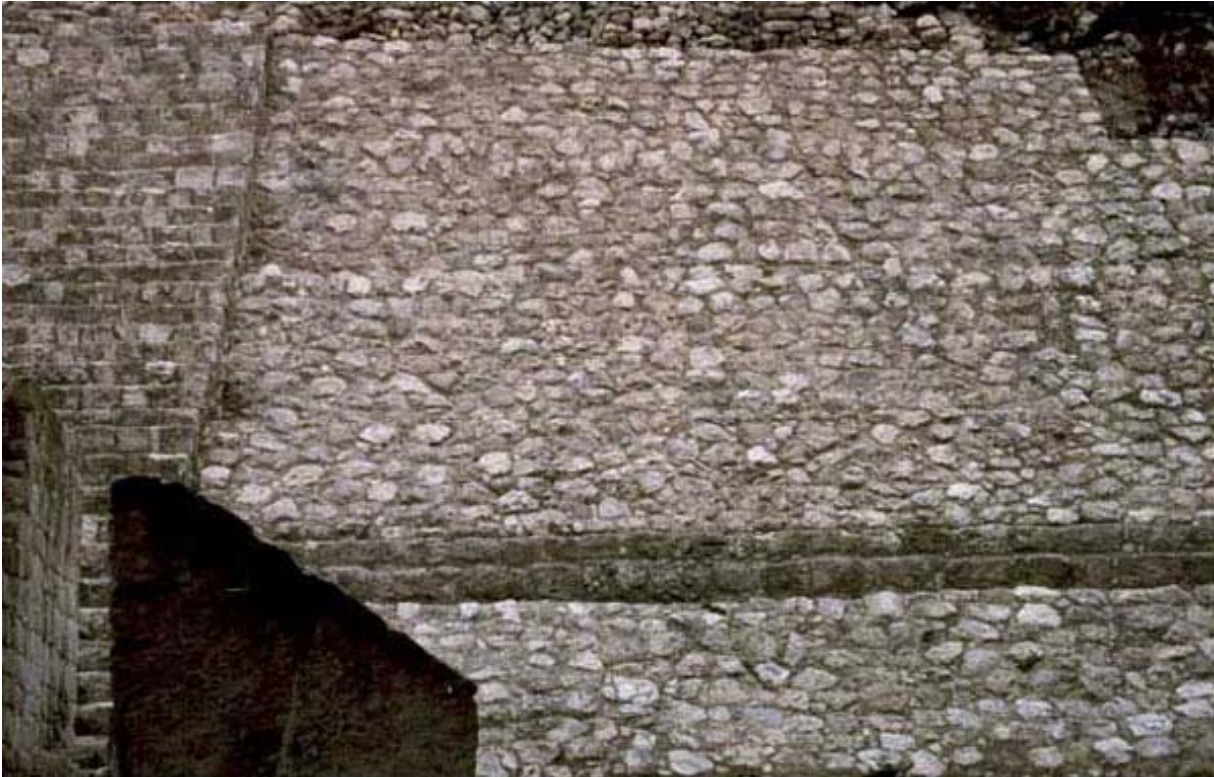
Foto 22. Calakmul, Estructura 1, detalle de restitución de volúmenes y cambio de textura, 25 de julio, 2000.
