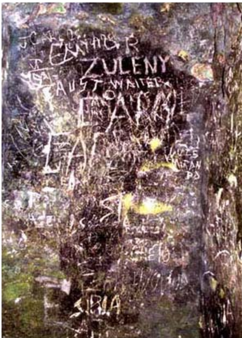
Foto 56. Tikal, Estructura 5D-33 2ª, interior de la cámara con grafitos modernos sobre el estuco original. El deterioro aquí se debe a la mano del hombre y no a la humedad.
