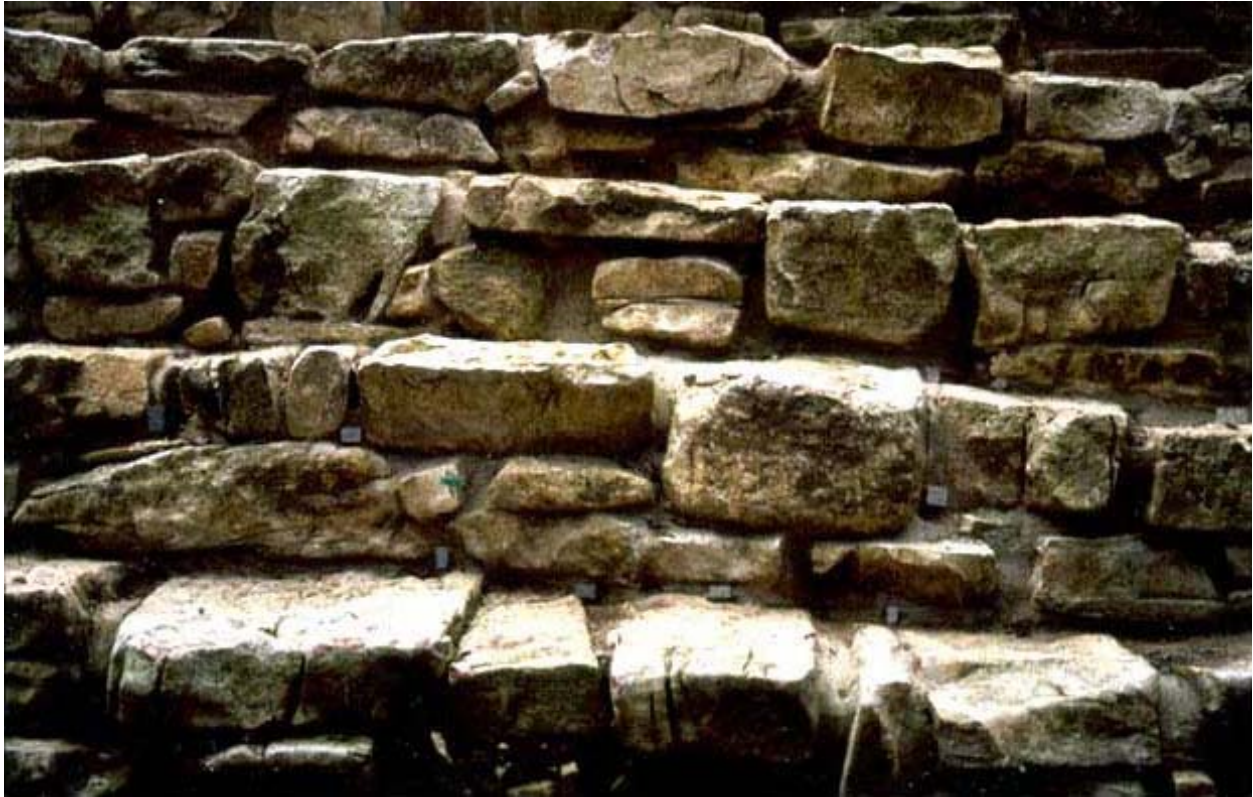
Foto 31. Palenque, Estructura XIX, detalle de integración de escalones señalada con piedras rectangulares en línea de puntos, 20 de marzo, 2000.
