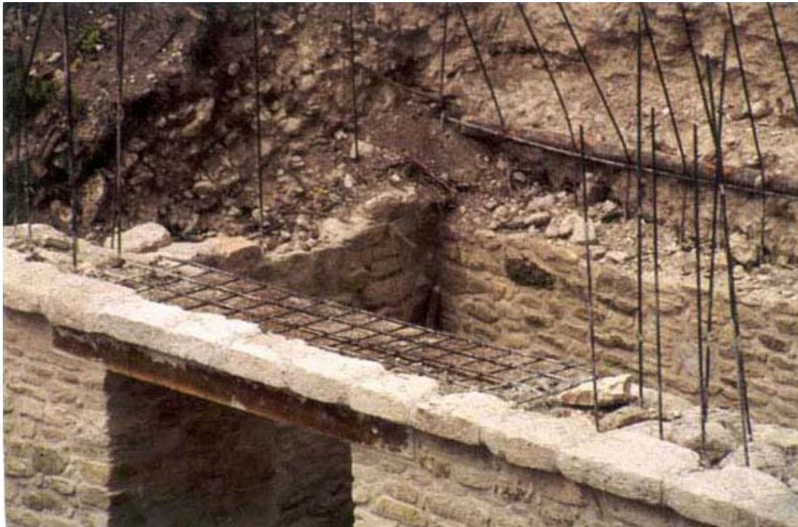
Foto 15. Cahal Pech, Estructura 19, durante la reconstrucción, para la cual se usaron numerosas barras de hierro, 12 de junio, 1992.
