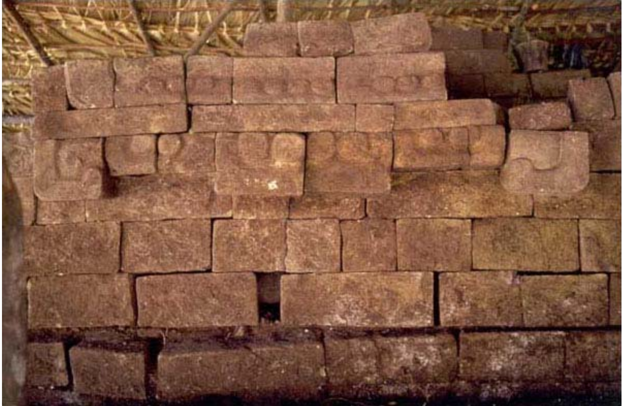
Foto 1. Copán, Estructura 9N-82, reintegración preliminar de los sillares en el lado este, 1981.
