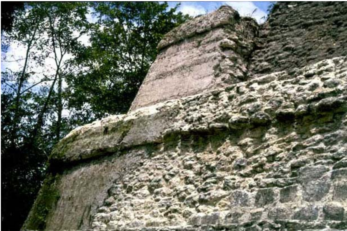
Foto 23. Yaxhá, Estructura 216, restitución de volúmenes, cambio de materiales, 27 de mayo, 2000.
