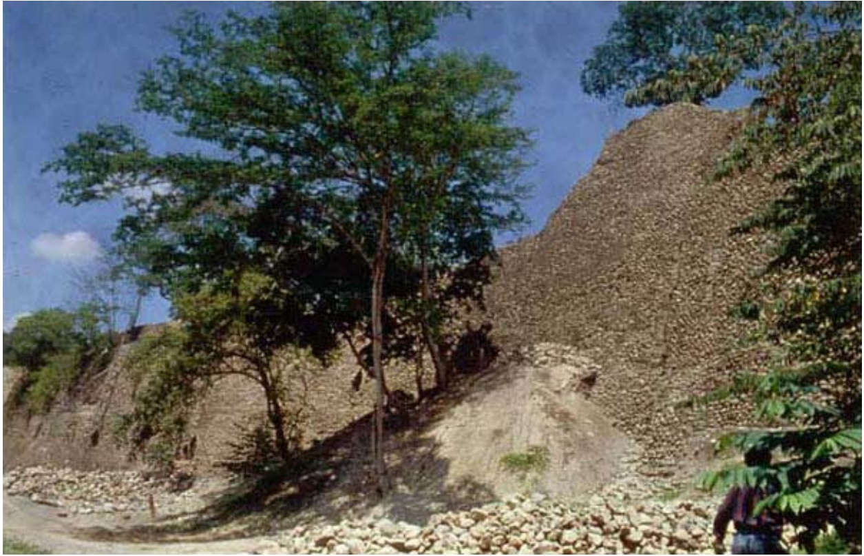
Foto 65. Copán, el corte arqueológico, vista general, en pleno trabajo de estabilización, 1993.
