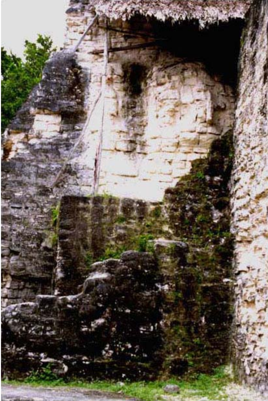
Foto 48. Tikal, Estructura 5D-22, idem foto 47, pero ésta fue tomada el 13 de diciembre del 2000; nótese que el mascarón casi ha desaparecido. Las partes húmedas con un marcado color oscuro aún se ven en condiciones mucho más aceptables que la parte techada.
