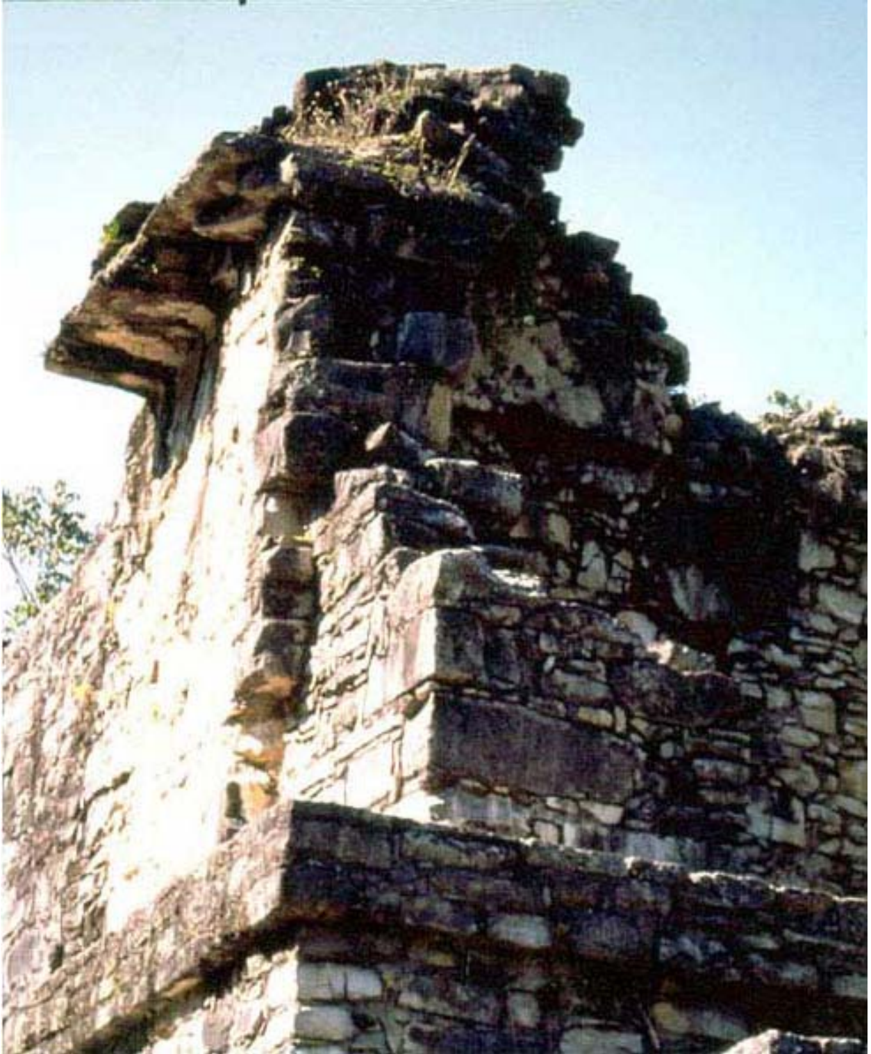
Foto 19. Palenque, Grupo de la Cruz. Uso de remetidos en una esquina, 2 de febrero, 2000.
