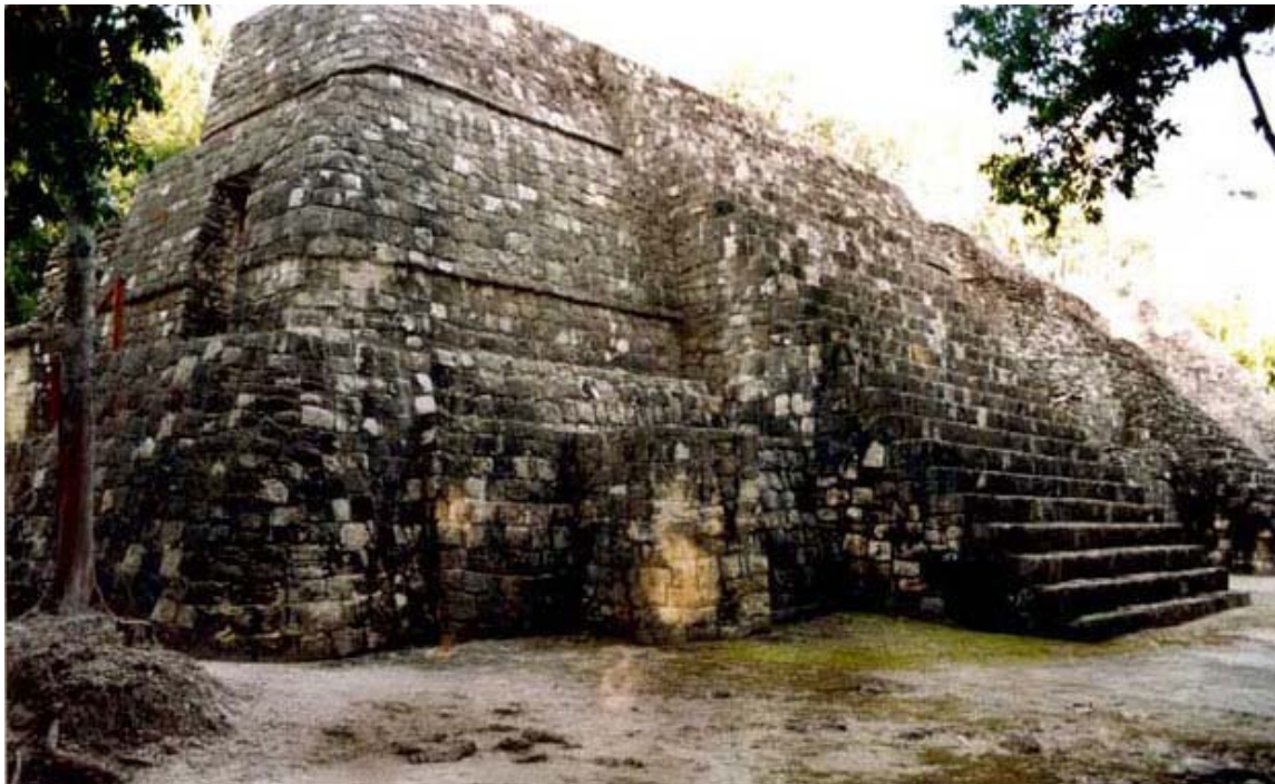
Foto 50. Balamkú, Casa de los Tres Reyes, después de la reconstrucción protectora, 18 de febrero, 2000.
