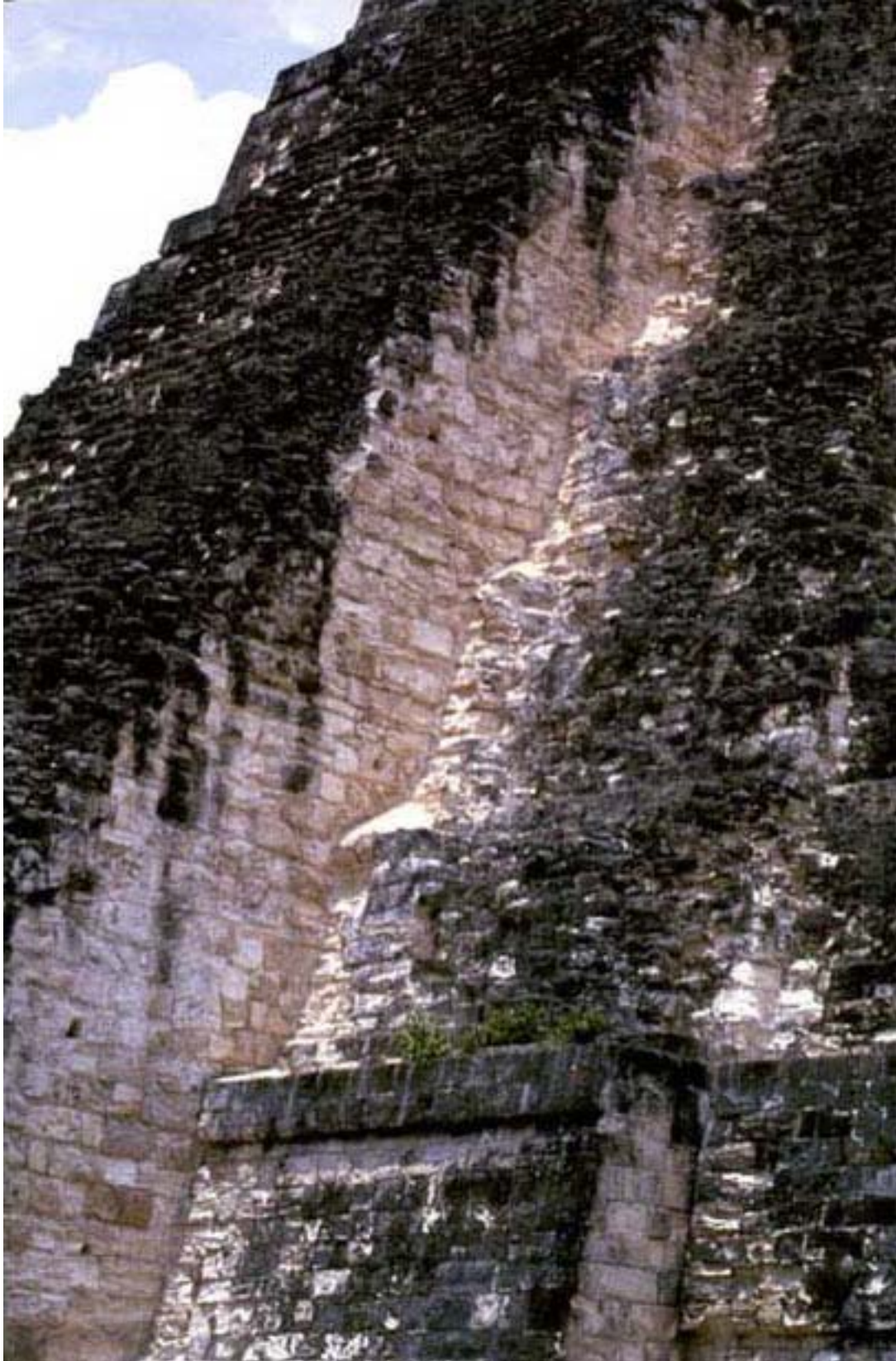
Foto 43. Tikal, Templo 1, lateral sur de la escalinata con un marcado deterioro; nótese el polvo blanco sobre las juntas con las terrazas, 14 de mayo, 2000.
