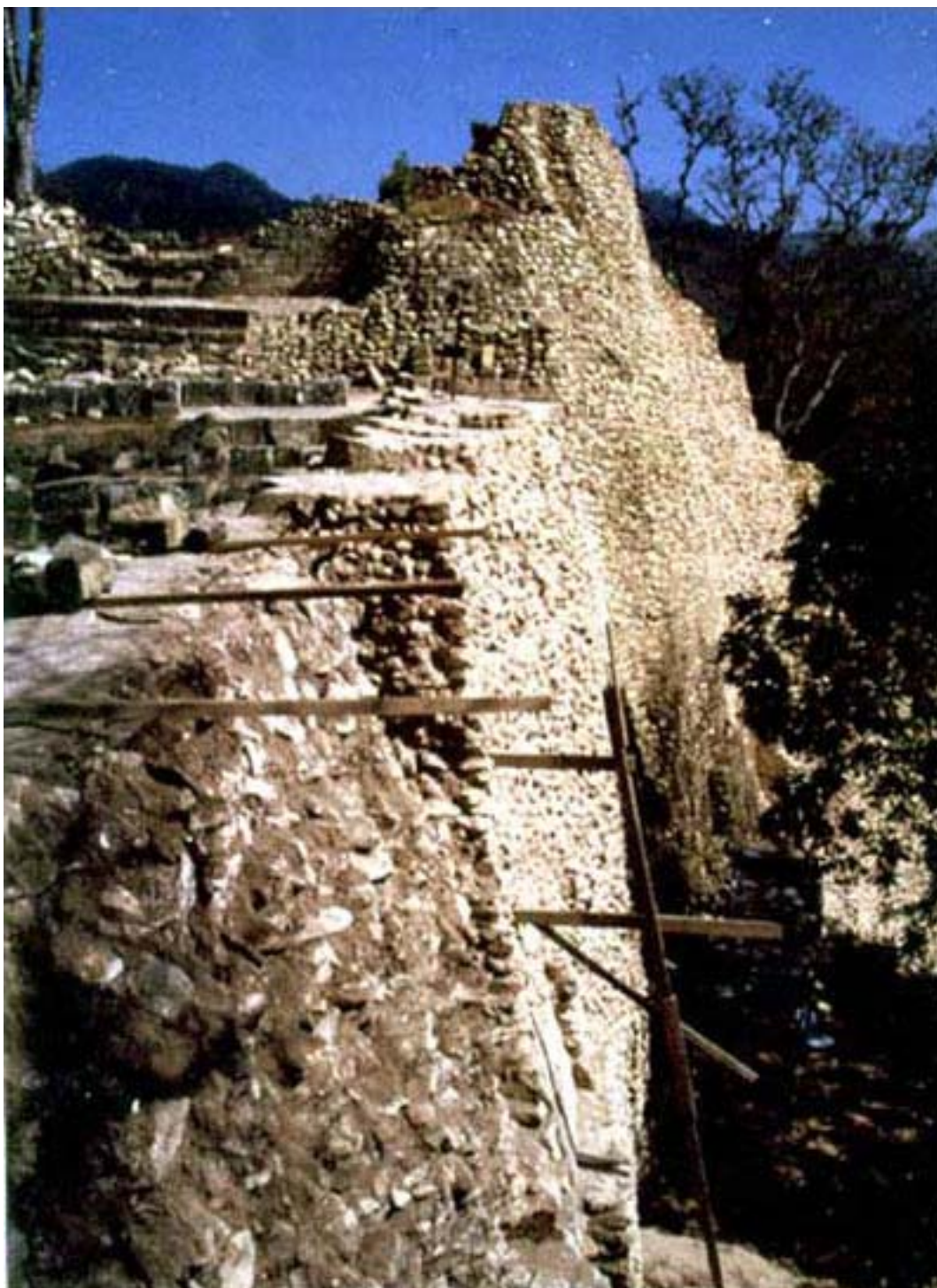
Foto 61. Copán, el corte durante los trabajos de estabilización. Detalle de colocación, 1992.
